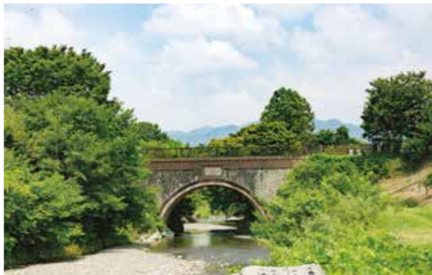
紀の川市内にある「龍之渡井」は紀の川の水を運ぶ穴伏川を横断する用水路。
